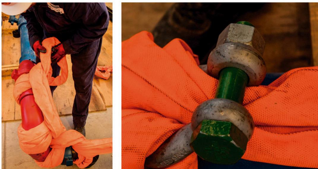
Al llegar a una "Tee" que cambie el sentido de flujo en 90°, se recomienda seguir el tendido en forma recta, realizando un medio ahorque en cada una de las uniones y recién a partir de la "Tee" realizar un ahorque completo y continuar el montaje del sistema de restricción hacia la nueva dirección.
